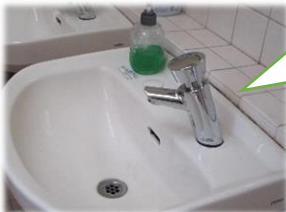
プッシュ式水道蛇口： 一押しで水が出て、 一定の時間で止まります
